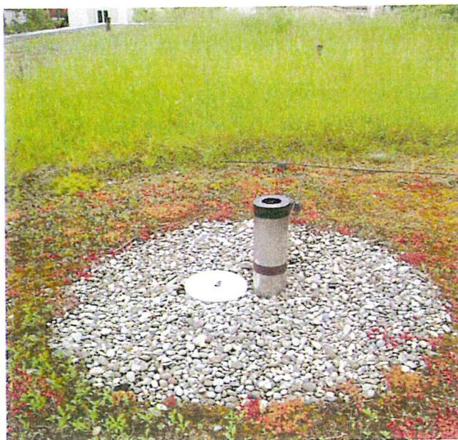
Abbildung 69: Extensivbegrünung mit vegetationsfreier Zone bei Dunstrohr und Dachwassereinlauf
