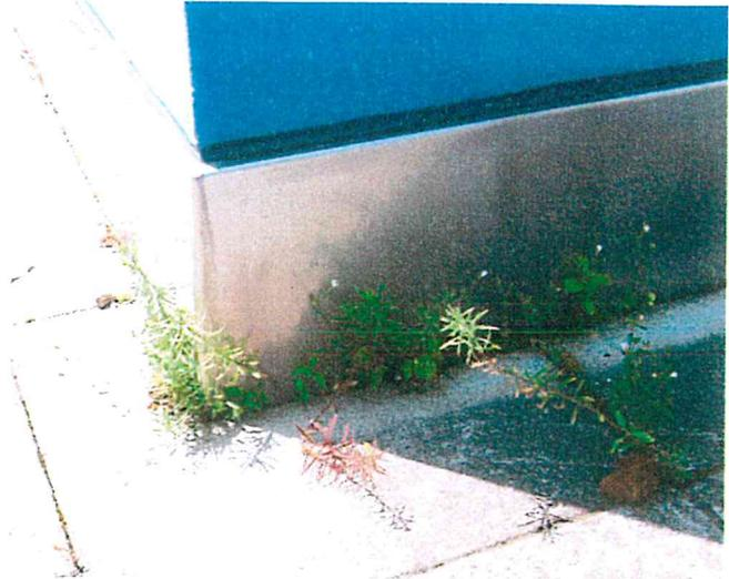
Abbildung 111: Ungewollter Pflanzenbewuchs bei begehbarem Dach infolge mangelhaftem Unterhalt
