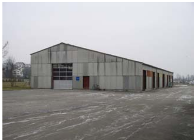
1 Mit Wellplatten aus Faserzement verkleidete Industriehalle
